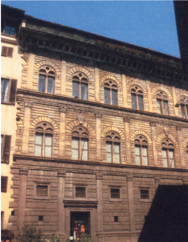
Abb. 121: Florenz, Palazzo Rucellai, 1446, Architekt L. B. Alberti
