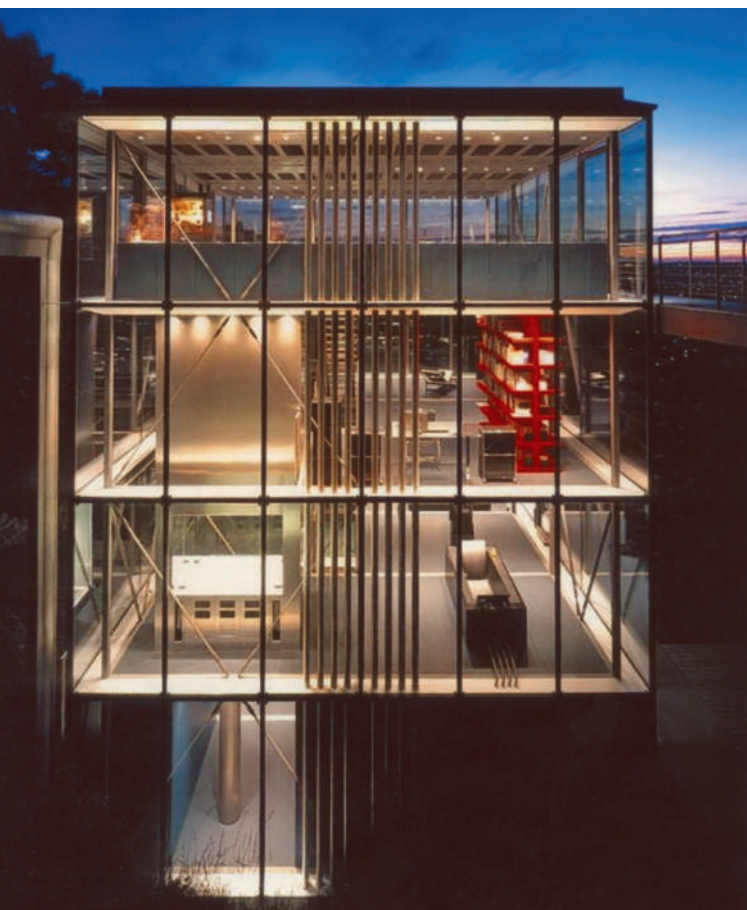
Abb. 257: Glaskubus Stuttgart, Architekt W. Sobeck, 2001
